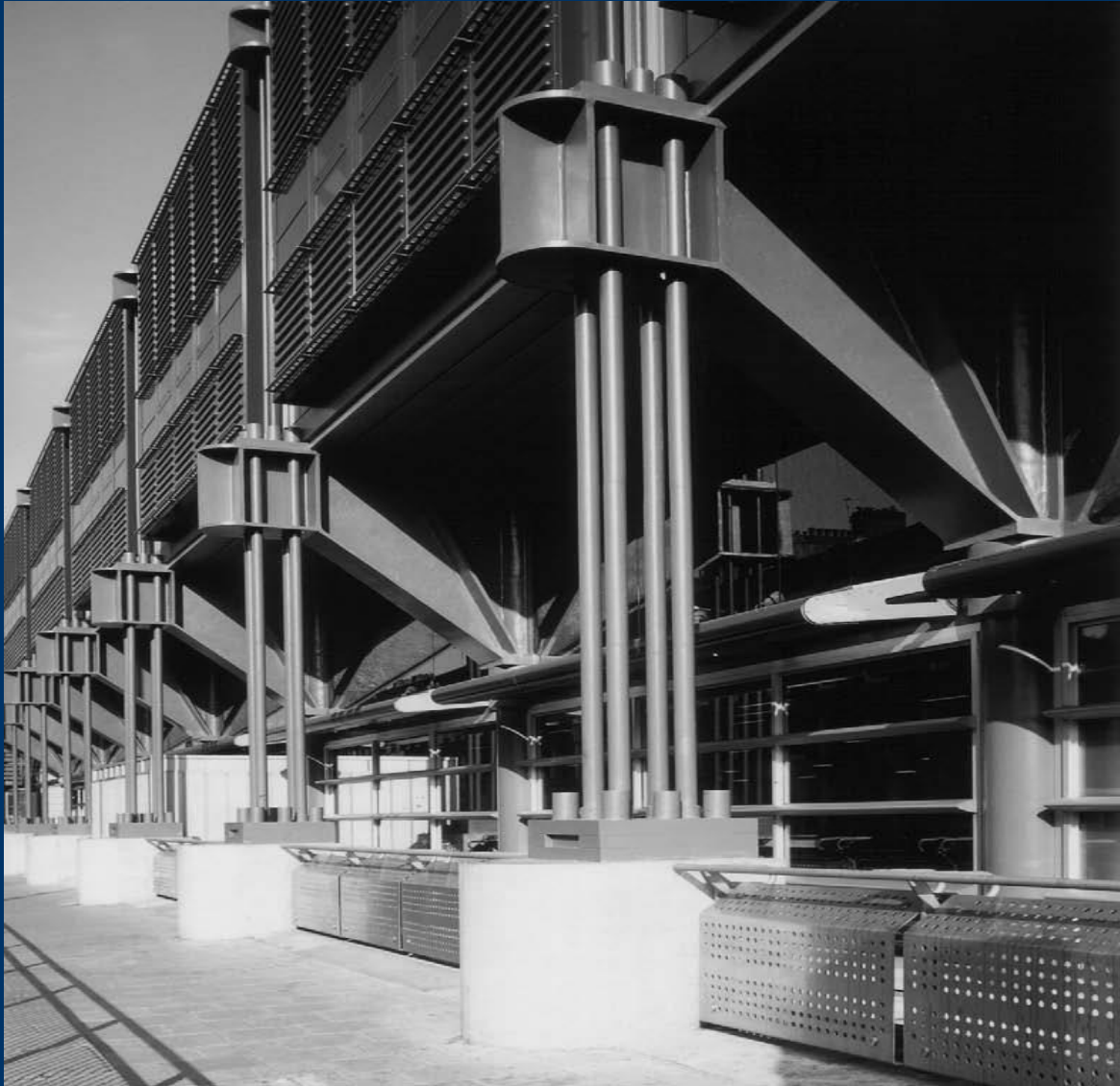
Wsporniki-prowadnice lin Sainsbury's supermarket (architekt: Nicholas Grimshaw & Partners)
