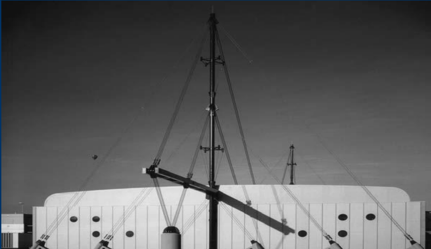
Konstrukcja cięgnowa -podwieszenie zadaszenia: Oxford Ice Rink , (architekt: Nicholas Grimshaw & Partners )
