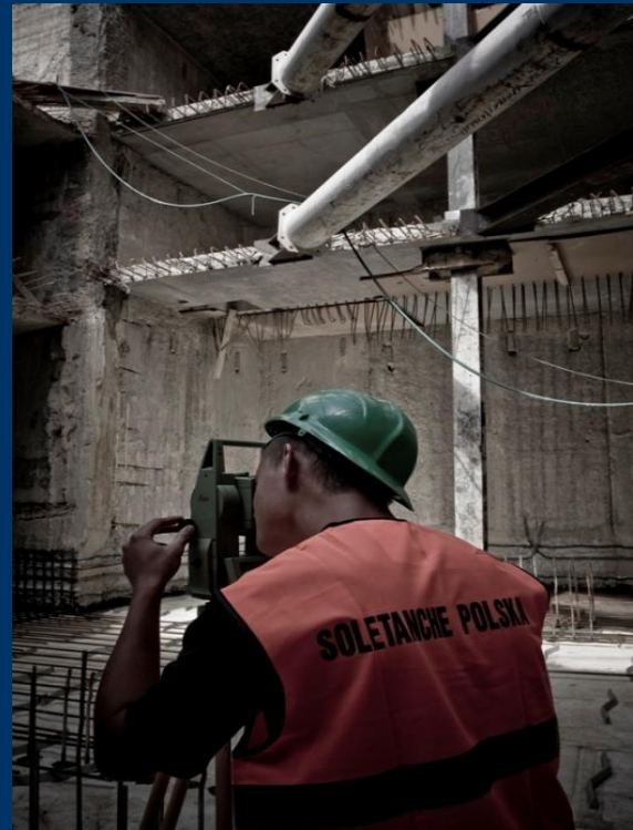
Prace wewnątrz obiektu wykonywanego metodą stropową [www. soletanche.pl]
