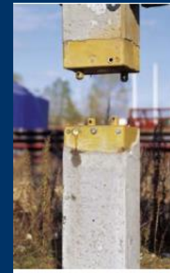
Głowice pali po osadzeniu
