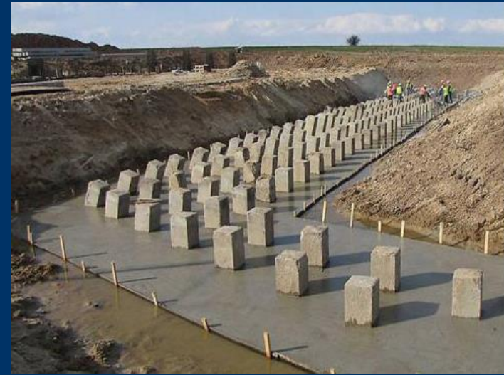
Głowice pali po osadzeniu
