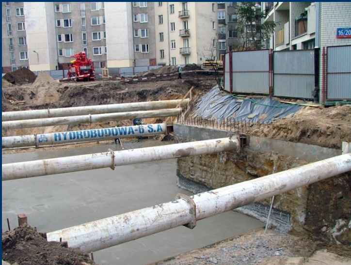
Realizacja rozparcia obudowy po garaż podziemny [Michalak H, Górnictwo (2009)]
