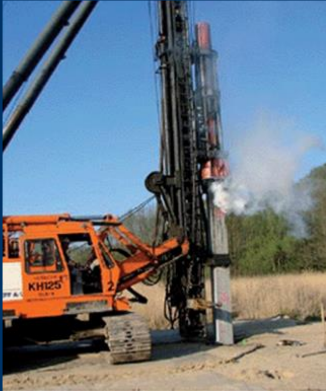
Pal żelbetowy w czasie instalacji (długość 43 m)
