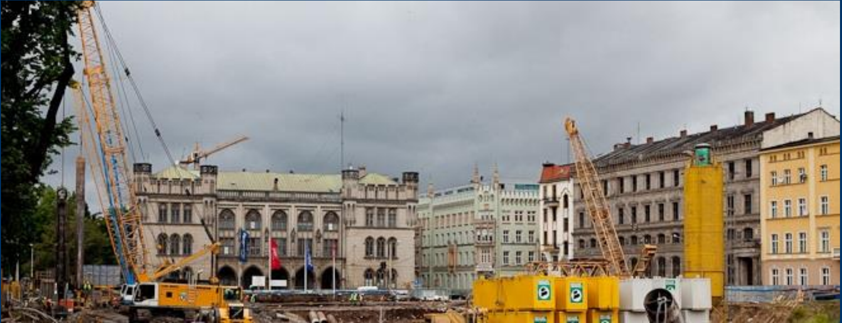
Budowa Narodowego Forum Muzyki we Wrocławiu w ścianach szczelinowych [projekt Chodor-Projekt] (2009)
