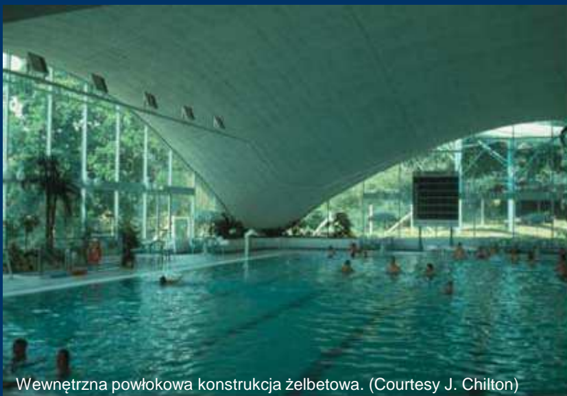
Powłoka żebrowana żelbetowa.
