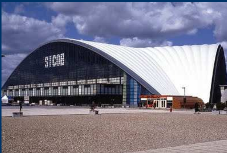
CNIT Exhibition Hall, Paryż , 1982 arch . Nicolas Esquillan, - Analog igloo – powłoka żelbetowa
