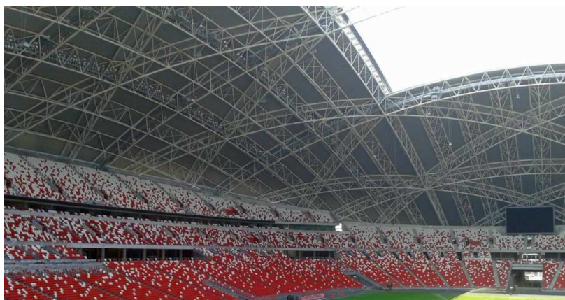
Rys.103.Konstrukcja kopuły Singapore National Stadium [123].
