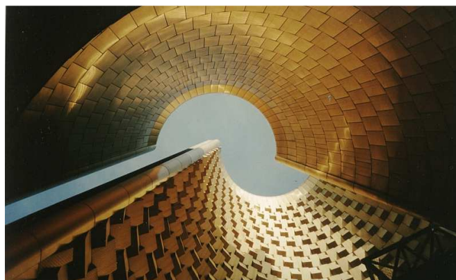
Rys.113.Blachy z wytłoczeniami na krzywiznie stożka [127]
