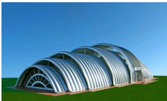
Rys.111. Hala łukowa z blach falistych [107]
