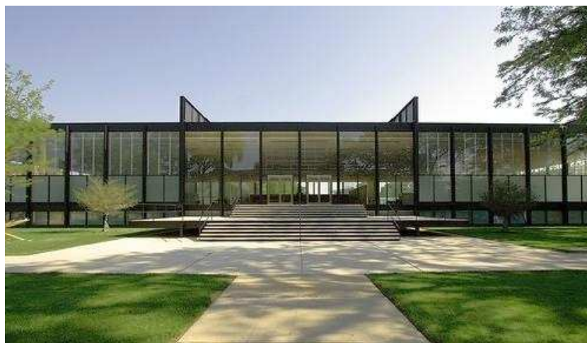
Rys.5. Hala stalowa z dominantą płaskich układów poprzecznych (Crown Hall) [90]
