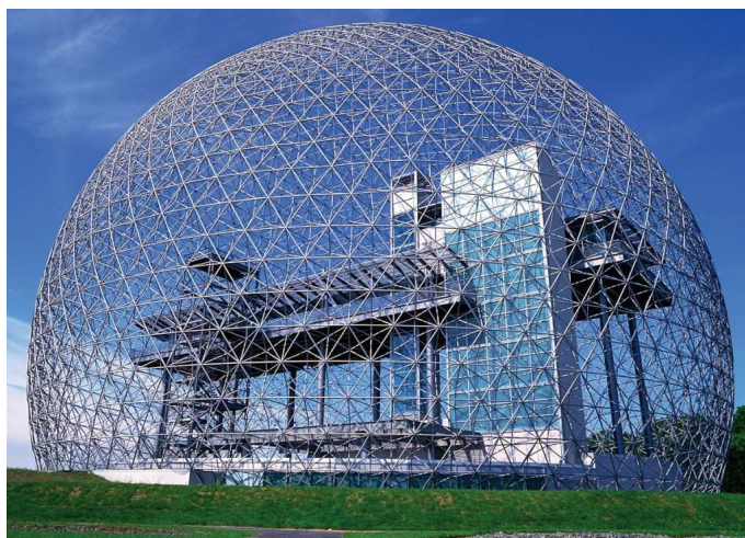
Rys.94. Kopuła geodezyjna Montreal Expo o średnicy 76 m, pokryta akrylem (Fuller, 1967)
