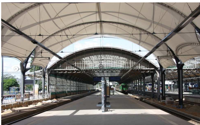
Rys.130.Zadaszenie cięgnowo - membranowe na dworcu PKP we Wrocławiu [60]
