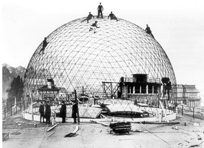
Rys.93. Pierwsza kopuła geodezyjna Carl Zeiss Jena (Bauersfeld, 1923)
