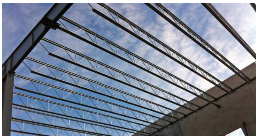
Rys.29. Płatew kratowa w systemie Butler Landmark™ 2000 [72]
