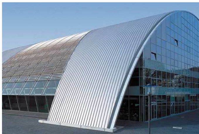
Rys.105. Przykład realizacji hali łukowej w systemie Floline [M1]
