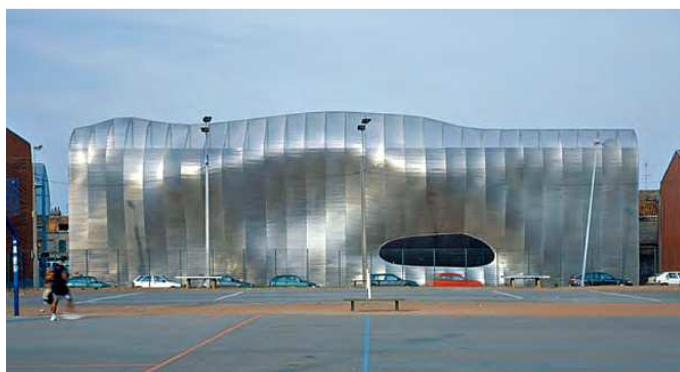
Rys.114. Blachy z nieregularnymi wytłoczeniami i krzywiznami [M9]
