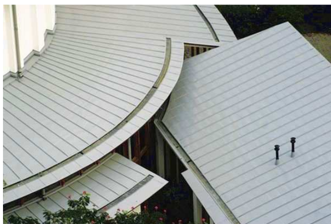
Rys.112.Przekrycie dwukrzywiznowe z blach płaskich na rąbek
